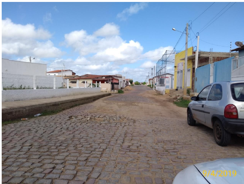
Imagem 03 – Rua Major João Pinheiro Bezerra Cavalcante - Bairro Maracujá. Coordenadas: 6° 13' 12.99" S / 36° 01' 18.96" O
