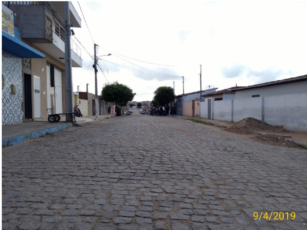
Imagem 06 – Rua Major João Pinheiro Bezerra Cavalcante - Bairro Maracujá. Coordenadas: 6° 13' 18.25" S / 36° 01' 31.69" O
