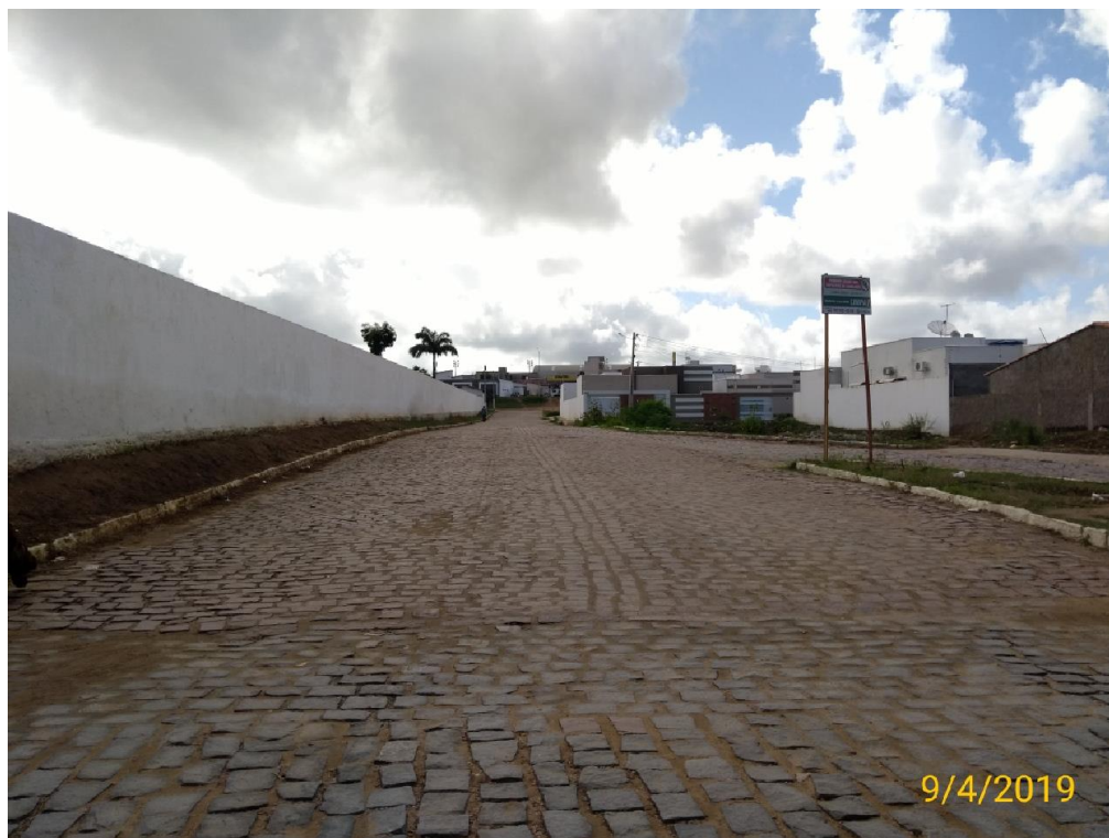
Imagem 02 – Rua Major João Pinheiro Bezerra Cavalcante - Bairro Nova Santa Cruz. Coordenadas: 6° 13' 12.51" S / 36° 01' 18.38" O
