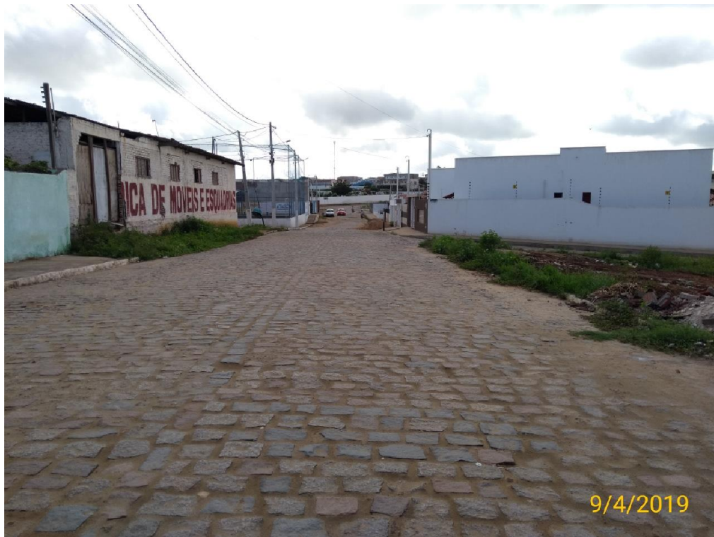
Imagem 04 – Rua Major João Pinheiro Bezerra Cavalcante - Bairro Maracujá. Coordenadas: 6° 13' 15.75" S / 36° 01' 25.36" O
