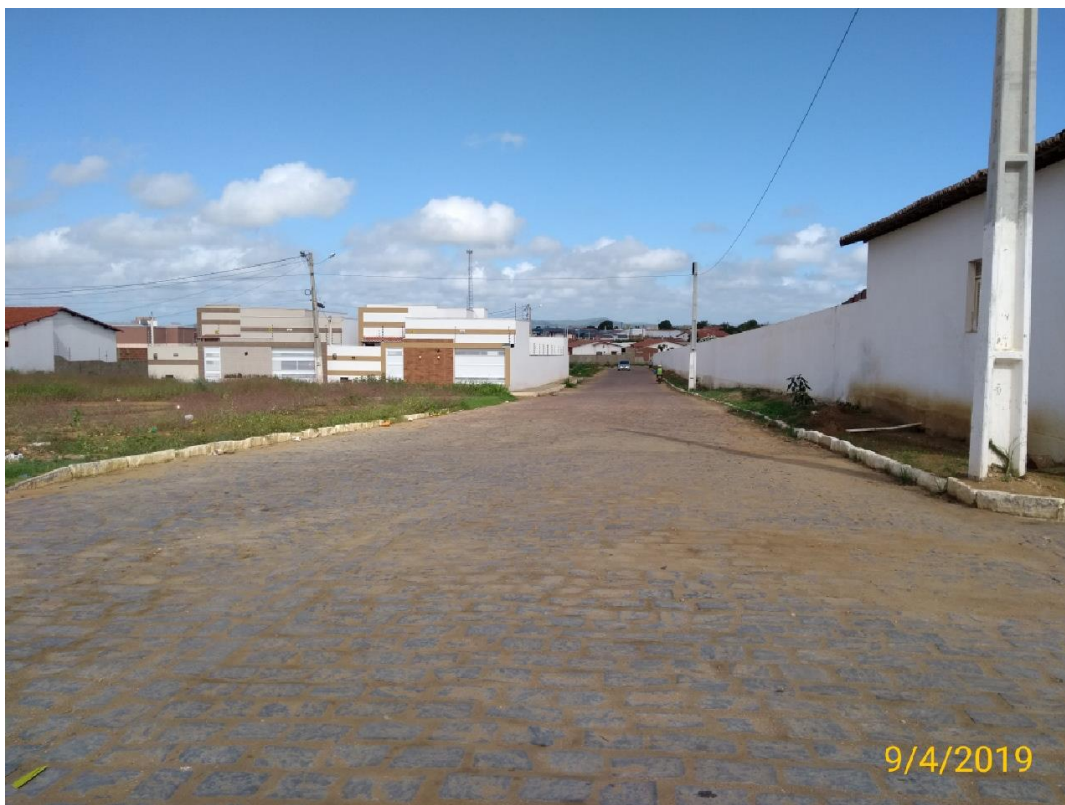
Imagem 01 – Rua Major João Pinheiro Bezerra Cavalcante - Bairro Nova Santa Cruz Coordenadas: 6° 13' 13.01" S / 36° 01' 13.75" O
