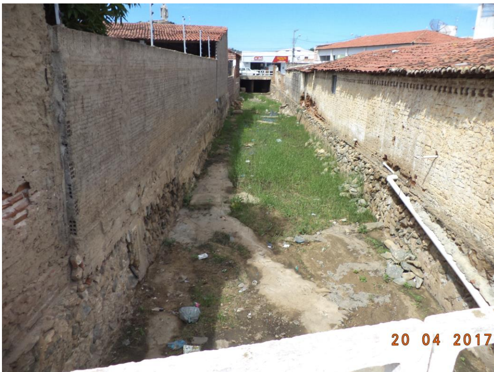
Imagem 03 – Visão do canal de drenagem de águas pluviais “Riacho do Pecado”, a partir da Rua João da Rocha Freire (sentido sul).
