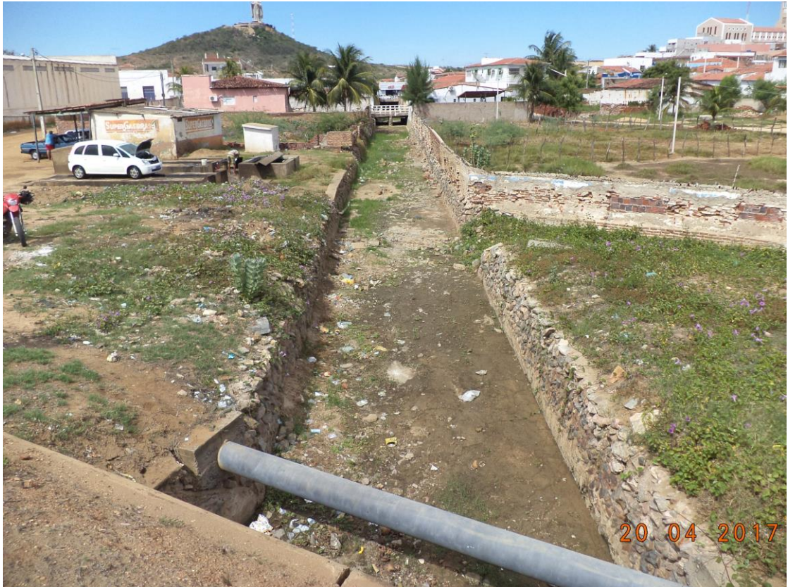
Imagem 01 – Visão geral do canal de drenagem de águas pluviais “Riacho do Pecado”, a partir da BR-226.
