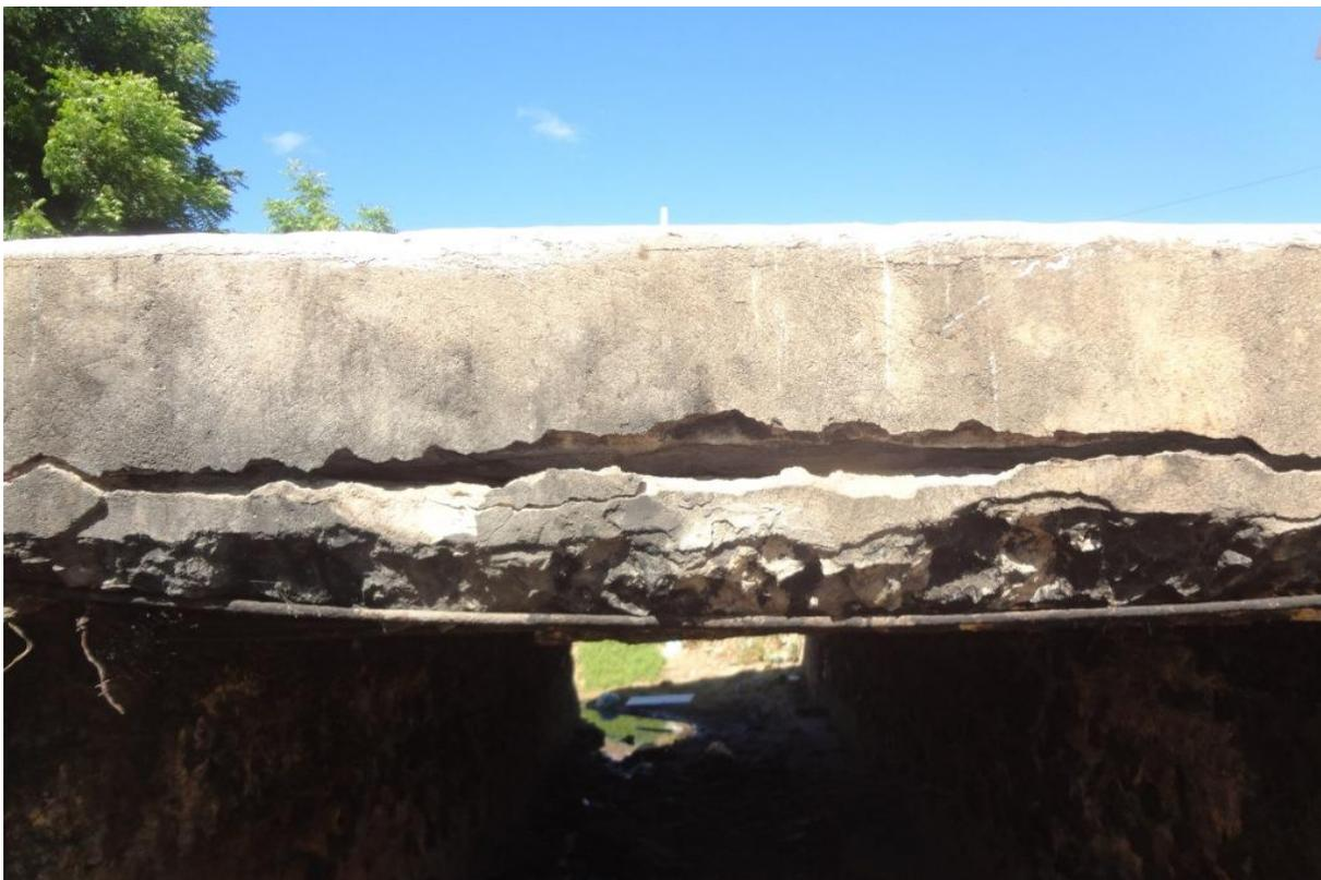
Imagem 03 – Vista lateral da viga de borda existente, com indicação que estrutura se aproxima de seu estado limite de ruptura, com armaduras expostas, deslocamento do cobrimento, perda de seção da armação por corrosão.
