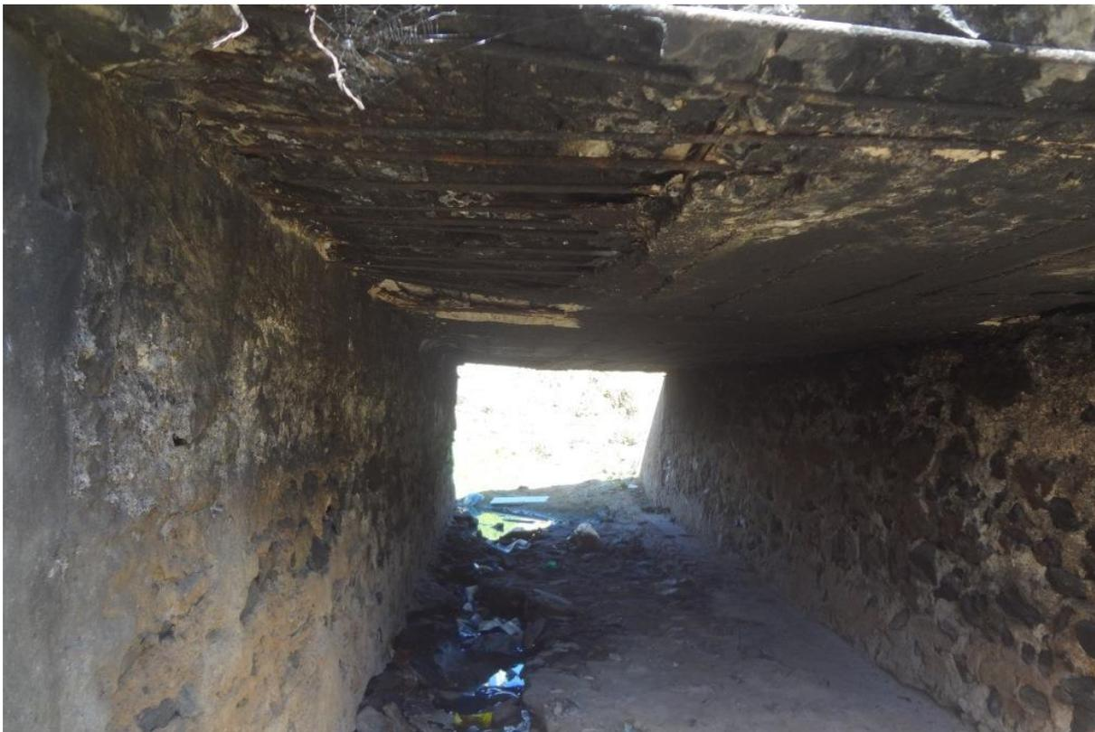
Imagem 01 – Visão interna do corpo do bueiro, onde verifica-se seccionamento de armadura inferior da laje, flecha acentuada, deslocamento de parte do concreto, indicando que a estrutura ultrapassou seu estado limite de serviço, e já apresenta sinais de ruptura ou colapso.
