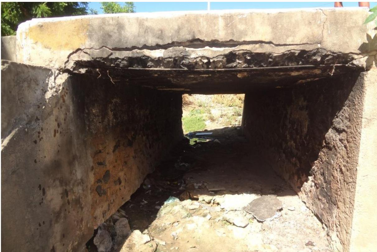
Imagem 02 – Visão geral do corpo do bueiro, onde verifica-se a ausência de piso adequado a estrutura, inclusive proporcionando desgaste progressivo na base (fundação) das paredes laterais.
