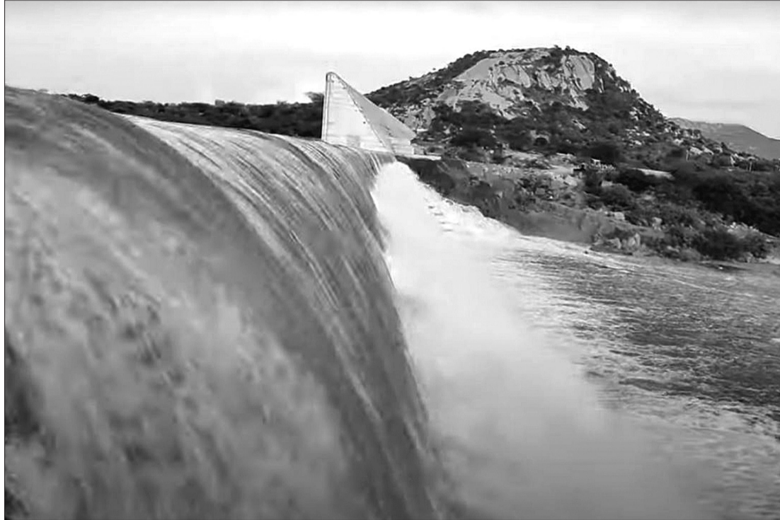
Barragem de Oiticica sangrou na última terça. Estado recebeu média de 135 milímetros
