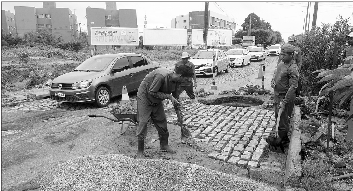
O problema se arrasta há cerca de um mês e foi gerado por obras na rede de drenagem da região, segundo a Seinfra
