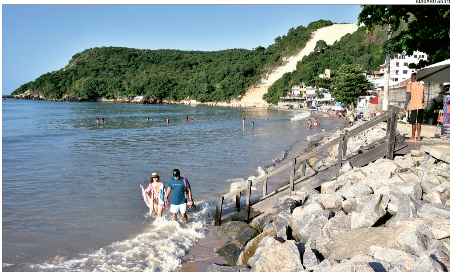
Obra da engorda é fundamental para impedir o avanço da erosão costeira em Ponta Negra. Prefeitura cobra celeridade
