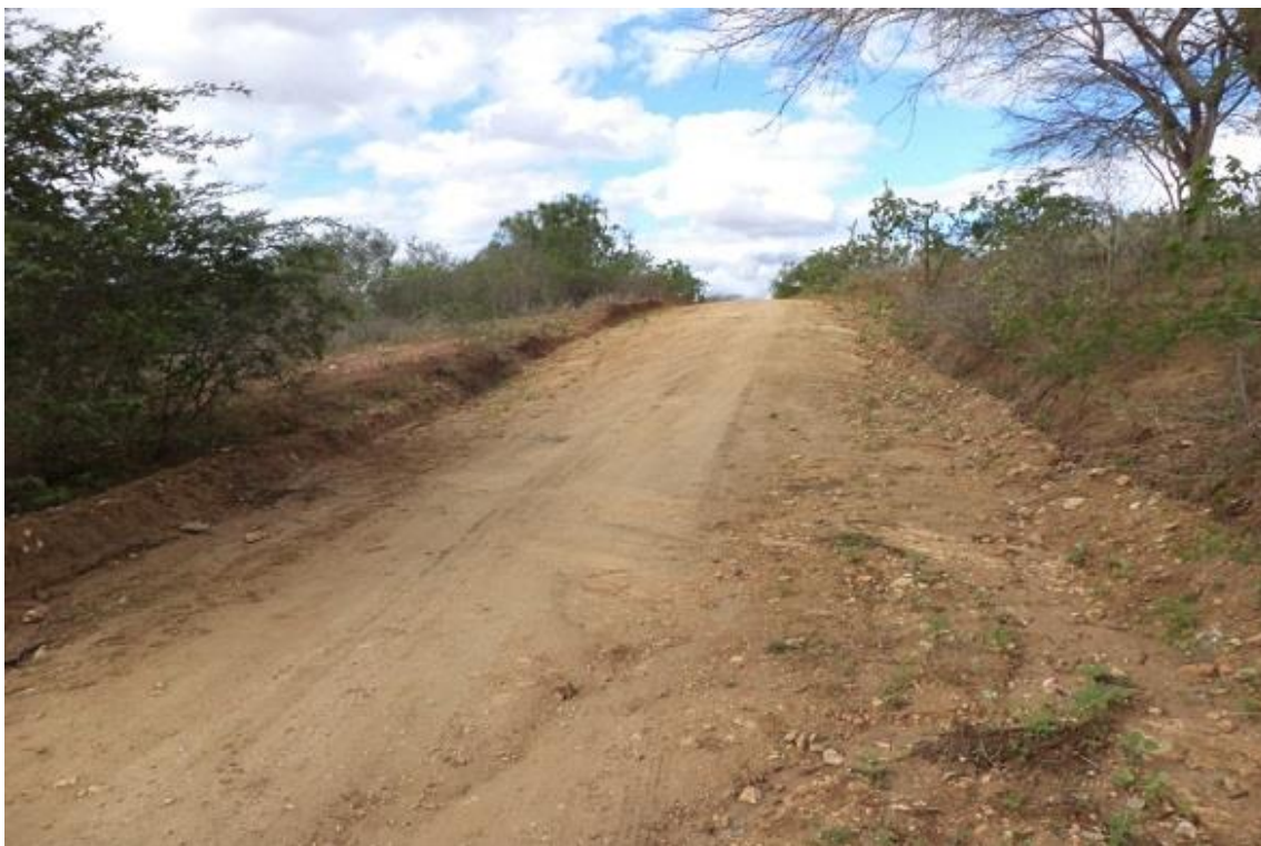
Imagem 01 – Acesso a Comunidade Chaves Bela na zona rural de Santa Cruz/RN (Trecho 1) Coordenadas: 6° 11' 36.15" S / 36° 02' 59.57" O
