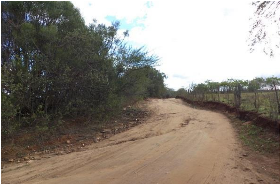
Imagem 02 – Acesso a Comunidade Bom Jardim na zona rural de Santa Cruz/RN (Trecho 2) Coordenadas: 6° 13' 47.31" S / 36° 01' 31.50" O
